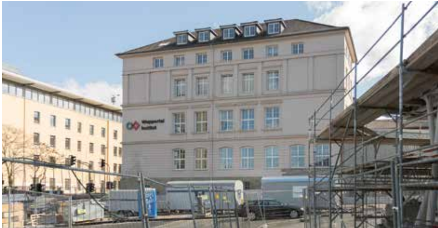
Ein sehr konkretes Bild auf die Verkehrsentwicklung haben die Mitarbeiter des Wuppertal Instituts beim Blick aus dem Fenster. Die Großbaustelle Döppersberg liegt direkt vor ihrer Haustür. Foto: Christoph Schönbach
